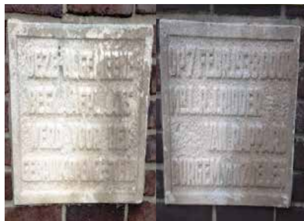
| Afbeelding 85 In de pilaren werden gedenksteden gemetseld. Op de linker steen staat de tekst: Deze algemene begraafplaats werd voor het gebruik opengesteld. Rechts: Op 7 febr. 1938 door Mr. L.R.J. Ridder van Rappard Burgem. van Zoelen.
