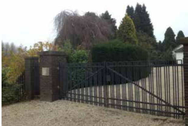
| Afbeelding 84 Hekwerk met pilaren bij de ingang van de begraafplaats. Over het geleverde werk omtrent de dekplaten waren opdrachtgever en -nemer het niet eens.
