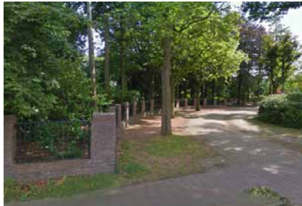
|Afbeelding 46 Op Begraafplaats Vredenhof in Tilburg dient een hekwerk als barrière om ongewenste personen en dieren buiten te houden.
