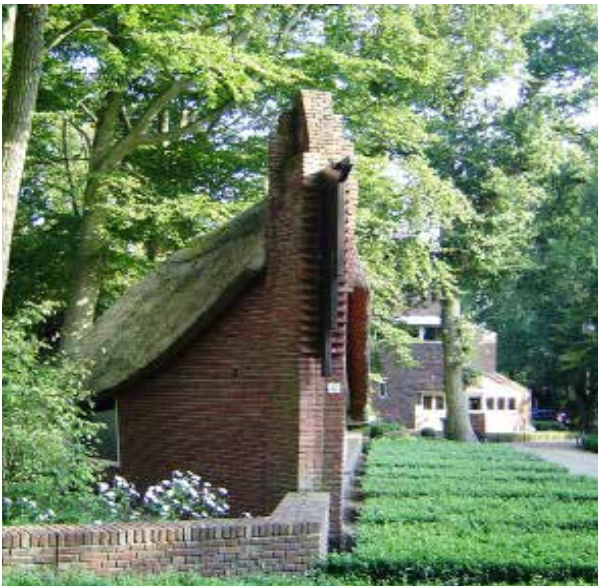
[Afbeelding 25 Woonhuis met berging in de Amsterdamse Schoolstijl in Bergen (Noord-Holland). De Organische vormgeving en variatie in metselwerk zijn kenmerkend voor deze stijl. Door middel van een muurtje worden huis en schuur met elkaar verbonden.
