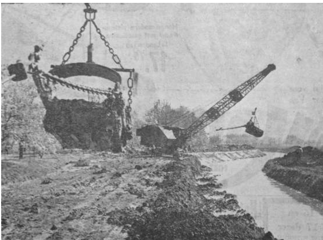
Afb. 22 “Twee reuzen groeven de Linge in overoude tijd’. In onze gloednieuwe tijd zijn het draglines, die de Linge graven door het malse Betuwse land. Een opname naar het Oosten langs de verruimde Linge tussen de oude rijksweg Arnhem-Nijmegen [anno 2016 de Rijksweg-Noord geheten] en de Drielseweg [nu de Grote Molenstraat] onder Elst, een van de weinige trajecten, waarop niet de Rijnwetering, maar de Waalwetering wordt verbreed. De nieuwe weg Bemmelen-Zetten komt hier ten Noorden van de nieuwe Linge te liggen.” Duidelijk te zien is hoe de wal die ooit tussen de twee weteringen lag naar één kant is geschoven. De nog losse grond waarop de draglines staan wordt later de locatie van de nieuwe weg, ter plaatse Eerste Weteringsewal geheten. Achter de dragline in het midden van de foto ligt de proefboerderij De Santakker, waar onder andere de Elstar appel ontwikkeld is.
