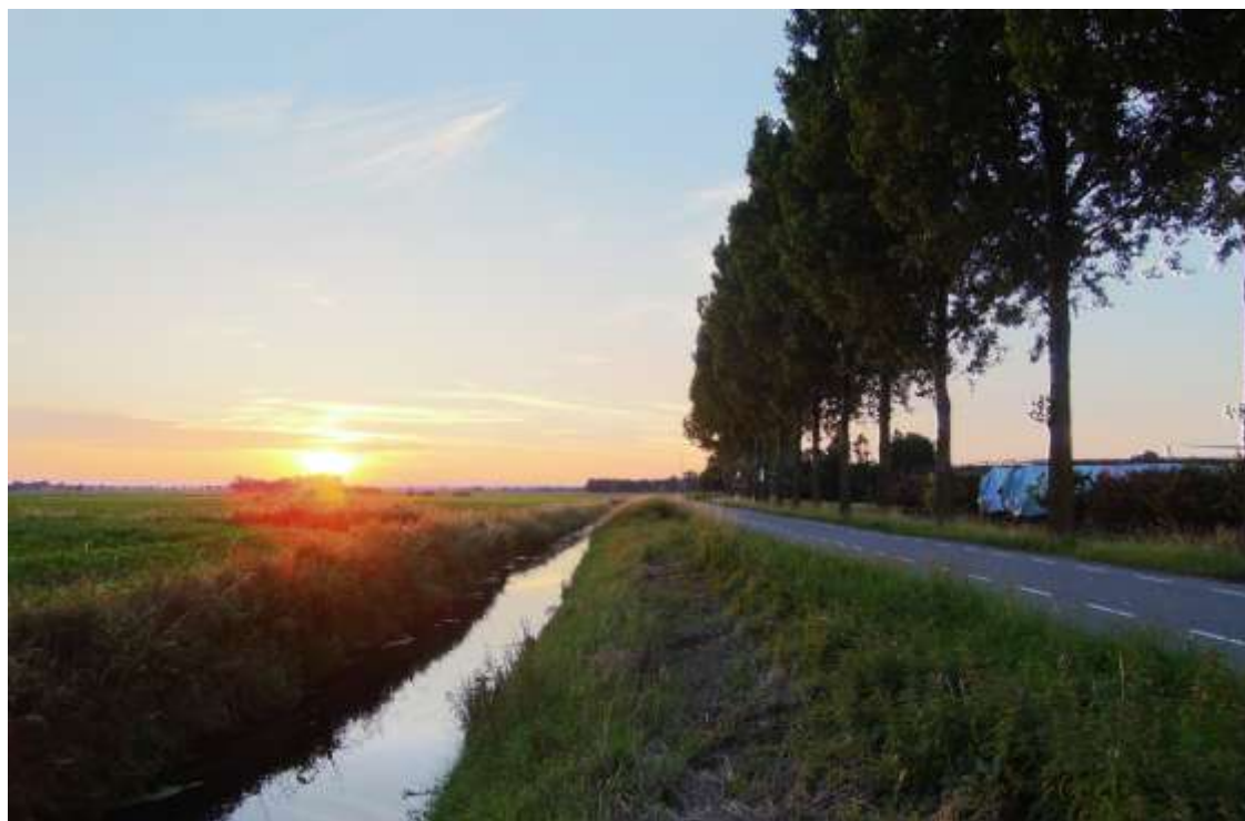
Afb. 35 (D) De Logtsestraat ten noorden van Valburg. De weg ligt op de kade die het Valburgsche Weiland (links) moet droog houden. De kavels die tegen de kade aan liggen zijn de lagere flanken van de stroomrug en liggen dus niet zo heel veel lager dan het land rechts van de kade. De kade markeert de grens tussen de dorpspolders Elst (rechts) en Valburg. Ook nu nog hebben de panden aan de ene kant van deze straat een adres in Elst en aan de andere kant een adres in Valburg. De rij populieren in de berm is een verschijnsel dat op meerdere plaatsen in de Over-Betuwe voorkomt, meest opvallend langs de Langstraat in het Hollanderbroek. Vermoedelijk hadden deze hetzelfde doel als de fruitbomen op de vorige foto: het verschaffen van extra inkomsten. De fruitbomen staan echter op de zavelige bodem van de stroomrug, terwijl men het op de kleiige bodems moest doen met populieren.
