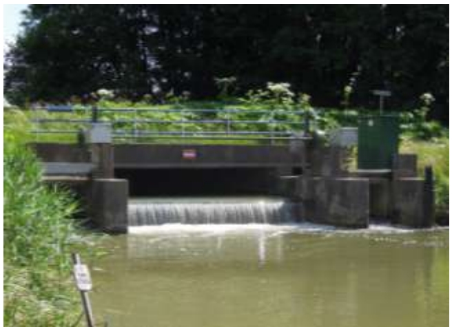
Afb. 27 De ingang (links) en de uitgang van de constructie die de Linge en twee zegen onder de Defensiedijk door voert. Achter de ingang is de autosnelweg A325 zichtbaar. De bomen op de achtergrond staan op de plaats van de Defensiedijk. Op de voorgrond zijn aan weerskanten van de Linge stuwen zichtbaar van het type dat in de jaren 1950 in de hele Over-Betuwe is geplaatst. De stuwen reguleren het waterpeil in de zegen en zijn zo de eerste werken in de geschiedenis van dit gebied die permanent goede waterstanden voor de landbouw bewerkstelligen. Dat de peilen tussen de Linge en de zegen verschillen, is goed zichtbaar op de rechter foto. De Linge wordt door de middelste, brede stuw op peil gehouden, geflankeerd door links en rechts een zeeg. Van met name de zeeg rechts op de foto is te zien dat de stuw lager staat dan die in de Linge.
