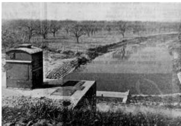
Afb. 23 “Van wetering tot rivier. De inlaatsluis bij Doornenburg, waar de verruimde Linge zijn loop tussen de Over-Betuwe bongerden begint. Foto genomen vanaf de nieuwe bandijk bij het Pannerdensch Kanaal, waarin de inlaatsluis is gebouwd.”
